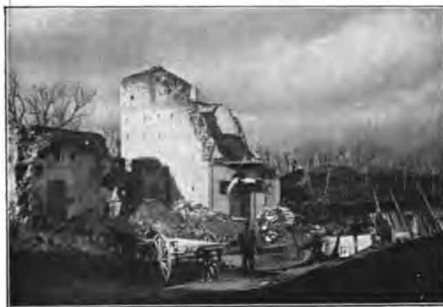
Fig. 310. — Maison effondrée à Ottajano ; la rue a été déblayée. (16 avril 1906.)
